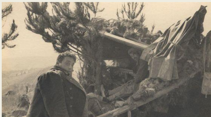
Requetés del Tercio de Navarra en una trinchera frente a Bilbao. (FPEV Fondo Javier Orbe Piniés).
